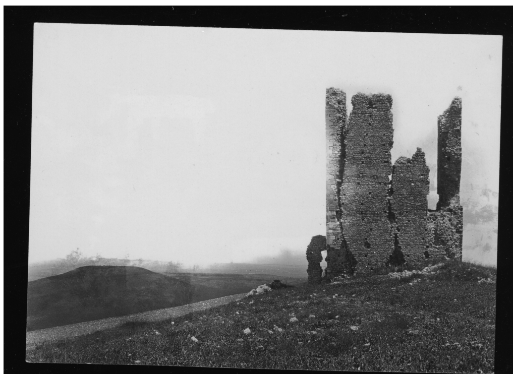
ill. 12 Tertiveri Wohnturm Westansicht
