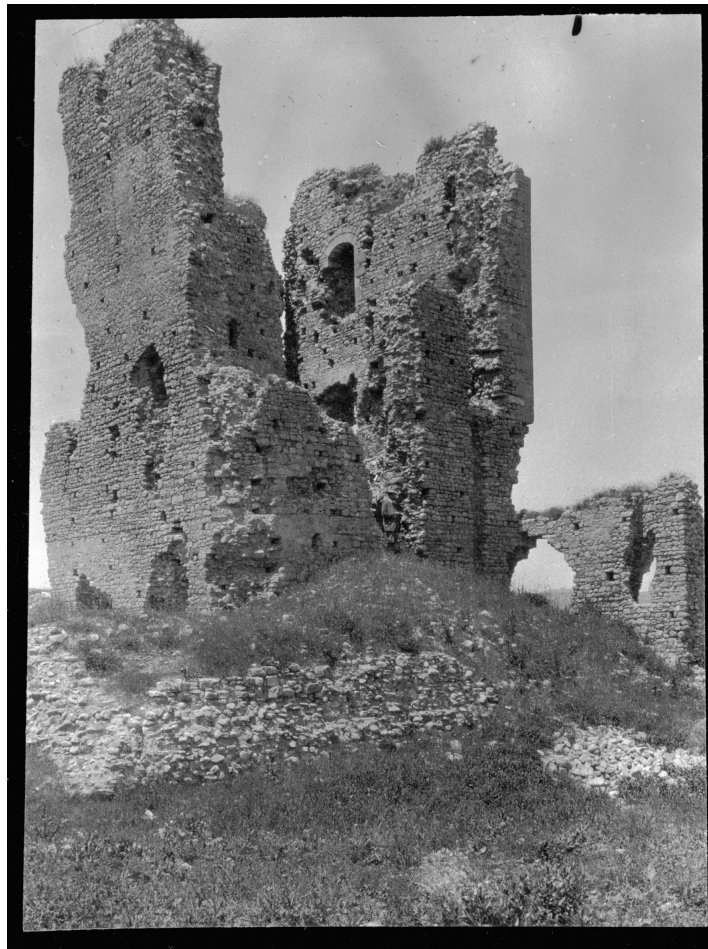
ill. 13 Tertiveri Wohnturm Südostansicht
