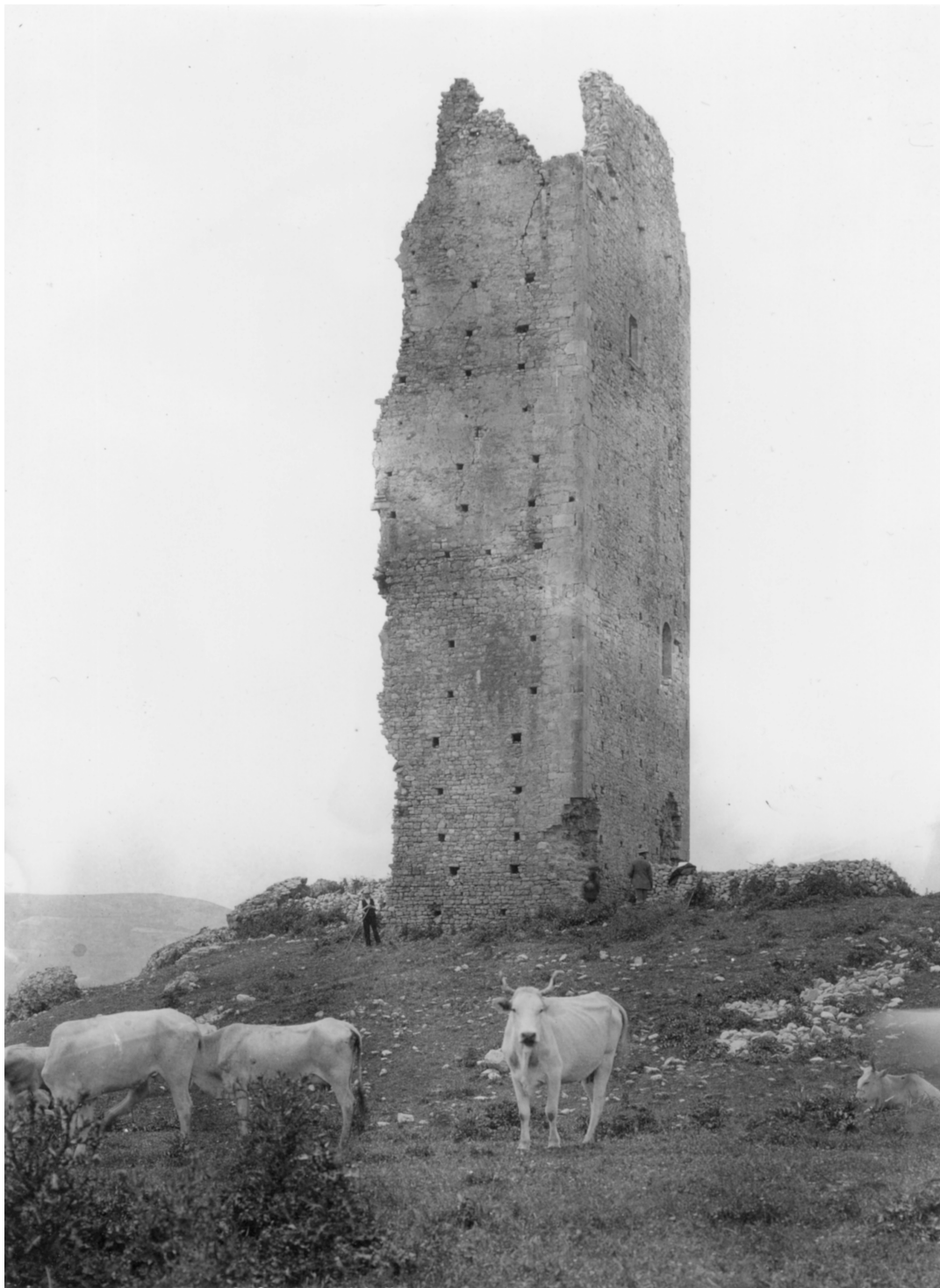
ill. 20 Nord-Ost-Ansicht Wohnturms Montecorvinoi
