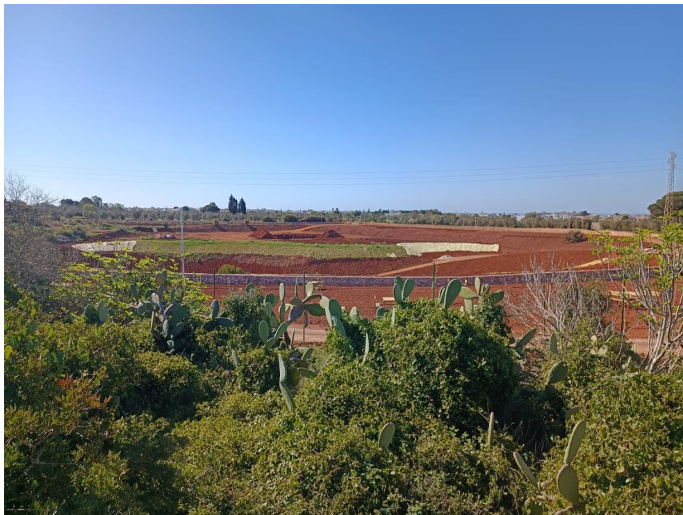
Fig. 11 a - Panoramica della dolina dopo l'intervento di messa in sicurezza.
