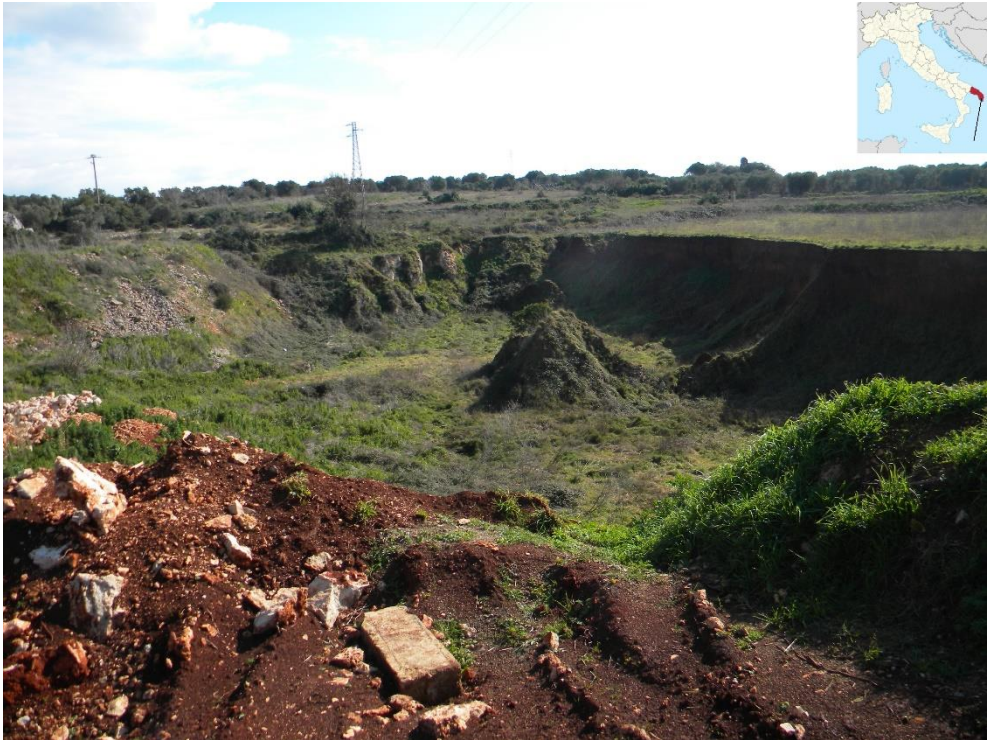
Fig. 10 - Panoramica della dolina di Spiggiani prima degli interventi di messa in sicurezza. In primo piano alcuni abbranchi di rifiuti.
