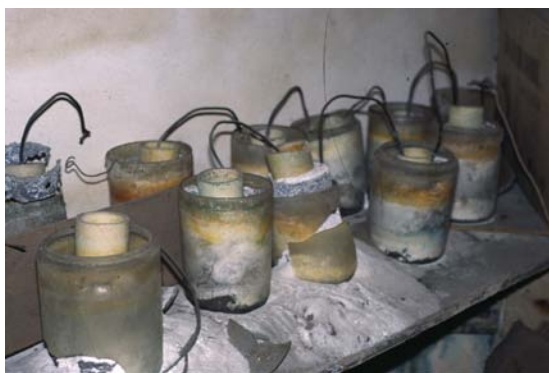
Fig. 7 - La batteria di pile a diaframma regolatore che alimentava la rete degli orologi, come fu ritrovata nel 1990. Purtroppo in seguito il tutto è andato disperso
